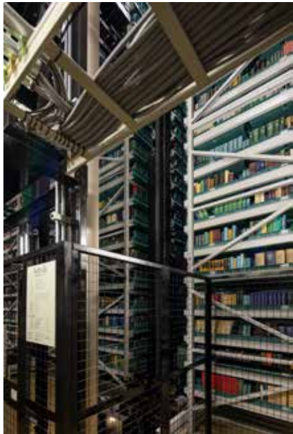
本館地下にある自動化書庫収納ステーション。 約30万冊もの本が保管されている。
